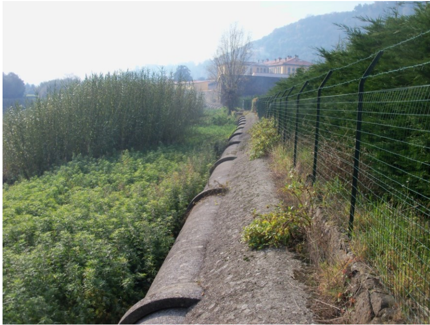
Figura 4 - Percorso vecchia tubazione in cemento in sponda Dx
