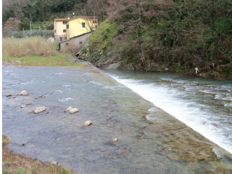
Figura 10 - primo attraversamento esistente
