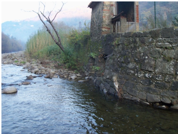
Figura 1 - Vecchia opera di captazione in disuso oggetto del ripristino sponda Sx
