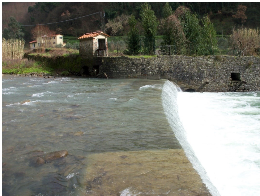
Figura 6 – Opera di presa attuale in sponda Sx
