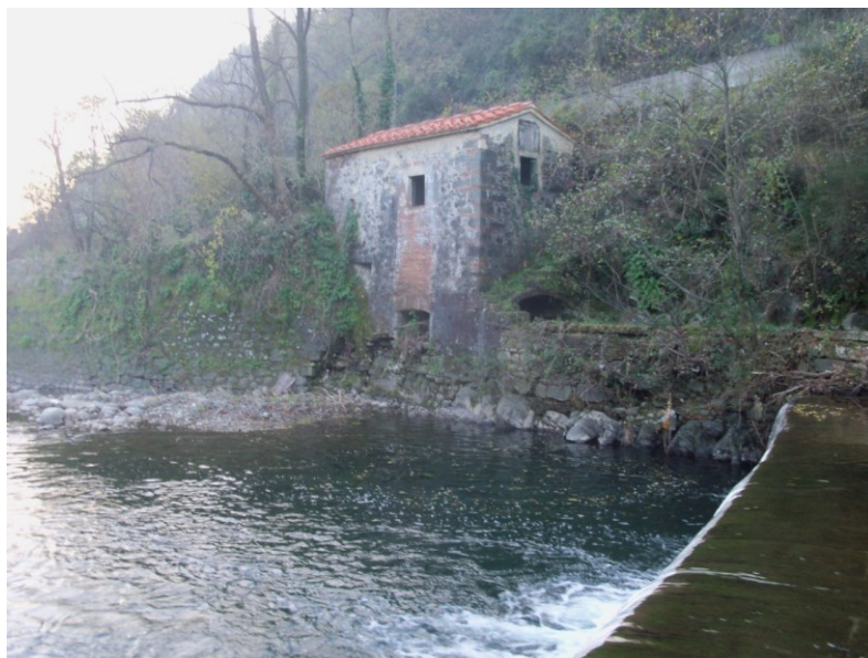
Figura 2 - Vecchia opera di captazione in disuso in sponda Dx
