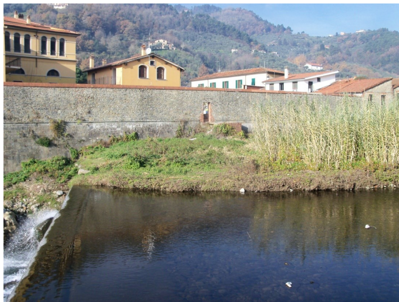
Figura 11 - termine della esistente tubazione in cemento
