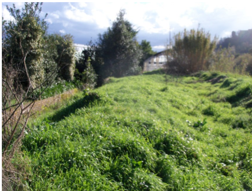
Figura 16 – tratto del vecchio canale in prossimità della centrale
