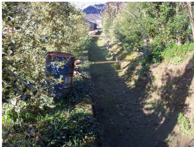
Figura 15 - tratto di vecchio canale in sponda sinistra
