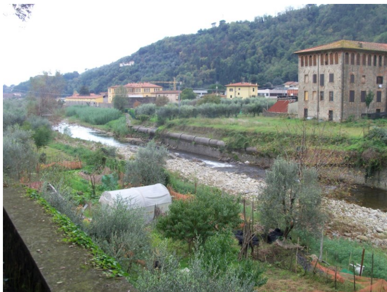
Figura 3 – Tubazione esistente oggetto del ripristino in sponda Dx
