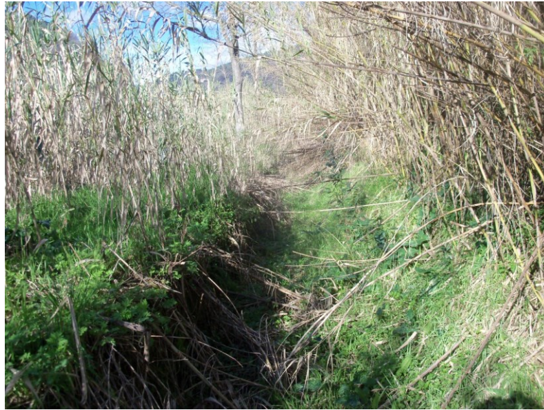
Figura 14 - Tratto di vecchio canale in sponda sinistra ricoperto da vegetazione
