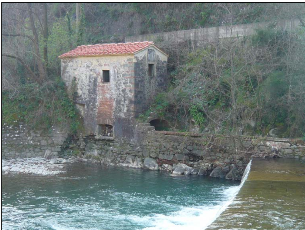
Briglia attuale in loc. Paradisino, sponda destra
