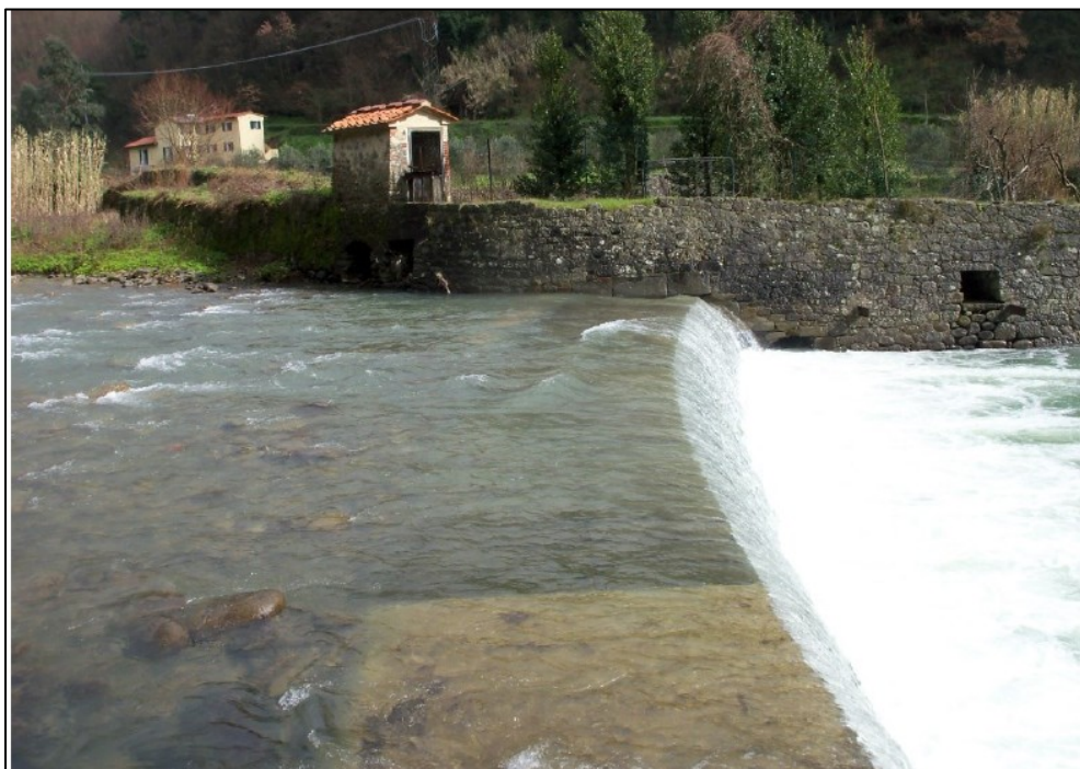
Sito dove verrà realizzata l'opera di presa – sponda sinistra –
