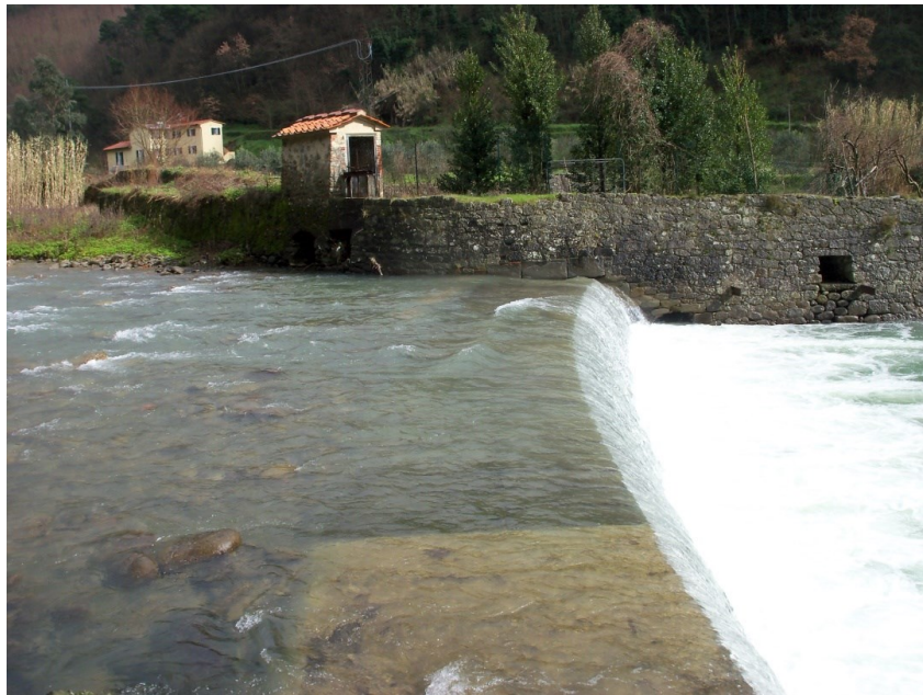
Figura 1 – Vista opera di presa attuale in sponda SX
