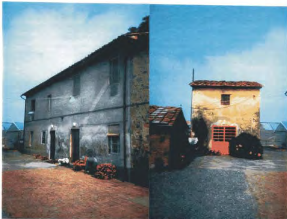
Rilevatori SPAZIO AMBIENTE s.r.l. 1992
