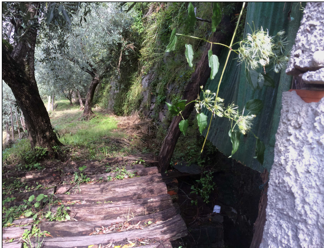
Foto n. 7 Piede del Muro di retta alla Viabilità PROVINCIALE in loc. Borgo G. Matteotti.
