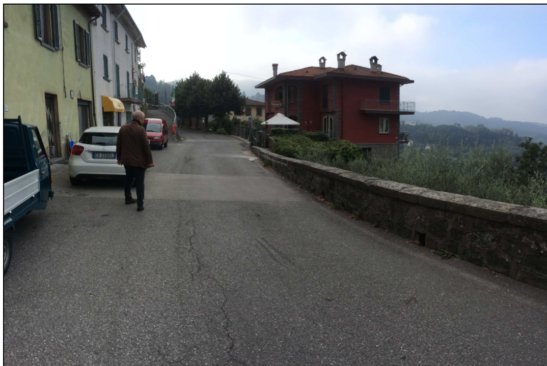
Foto n. 8 Testa del Muro di retta alla Viabilità PROVINCIALE in loc. Borgo G. Matteotti.
