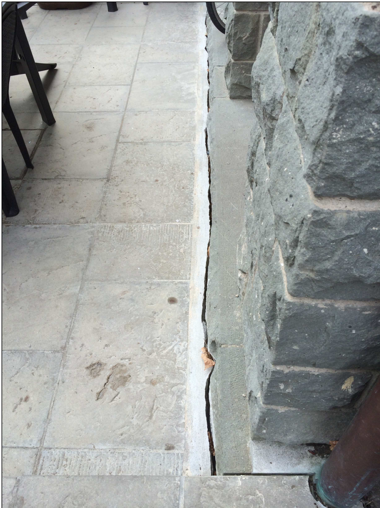
Foto n. 13 Lesioni su manufatti e opere d'arte alla Via PROVINCIALE in loc. Borgo G. Matteotti
