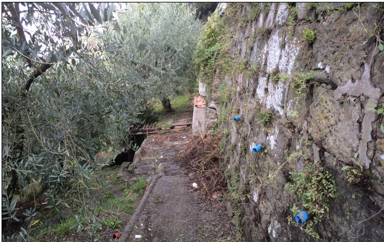
Foto n. 6 Piede del Muro di retta alla Viabilità PROVINCIALE in loc. Borgo G. Matteotti.
