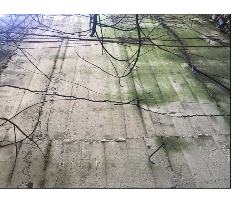
Foto 2: microfessure all'interno del muretto di recinzione, lesioni verticali all'altezza di circa 1,50m e in alcuni casi anche superiori.
