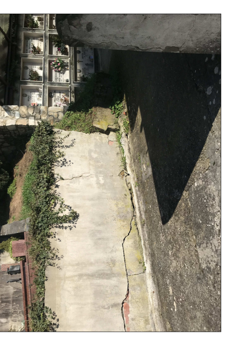
Foto 4: muro lesionato alla base scarpata sotto cappella Scaglietti, rotano verso valle.
