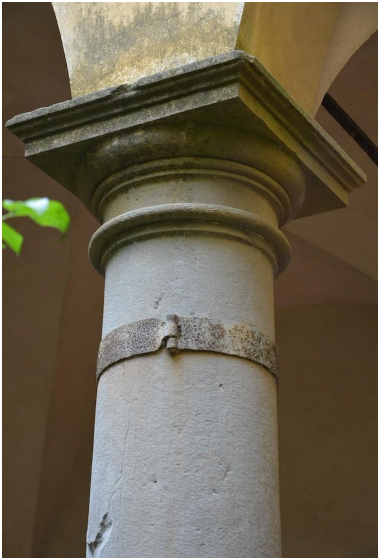
Cerchiatura du colonna del Chiostro B
