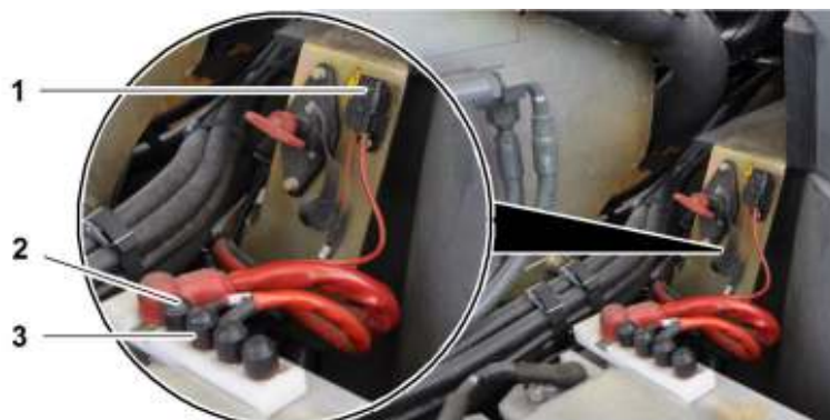
Fig. 273: Fusibili nel vano batteria
