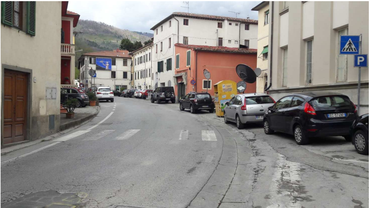
ATTRAVERSAMENTO N°5 – SP12 DELLE CARTIERE – Ex Scuola
