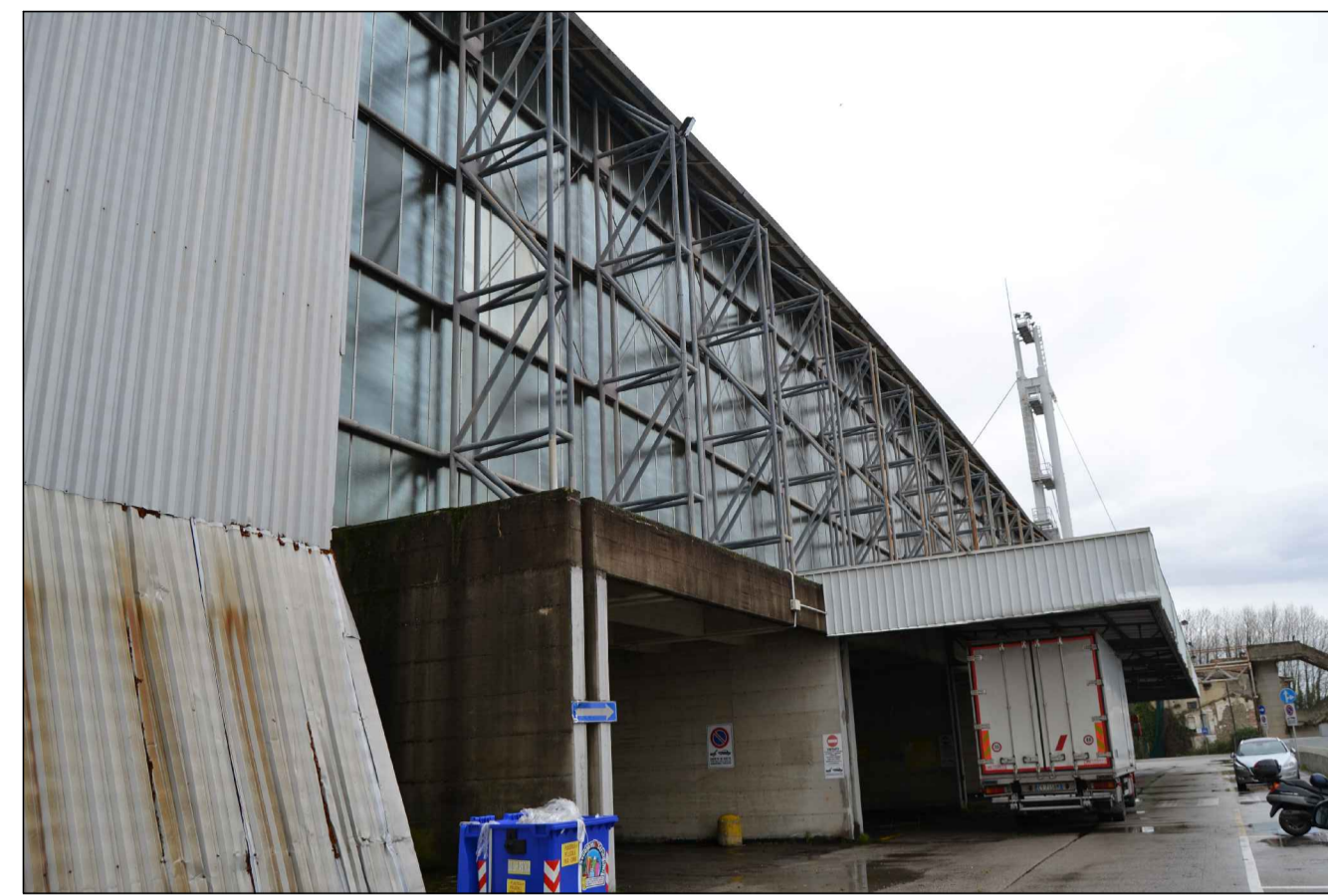
FOTO _ VETRATA SUD PARTICOLARE ESTERNO
