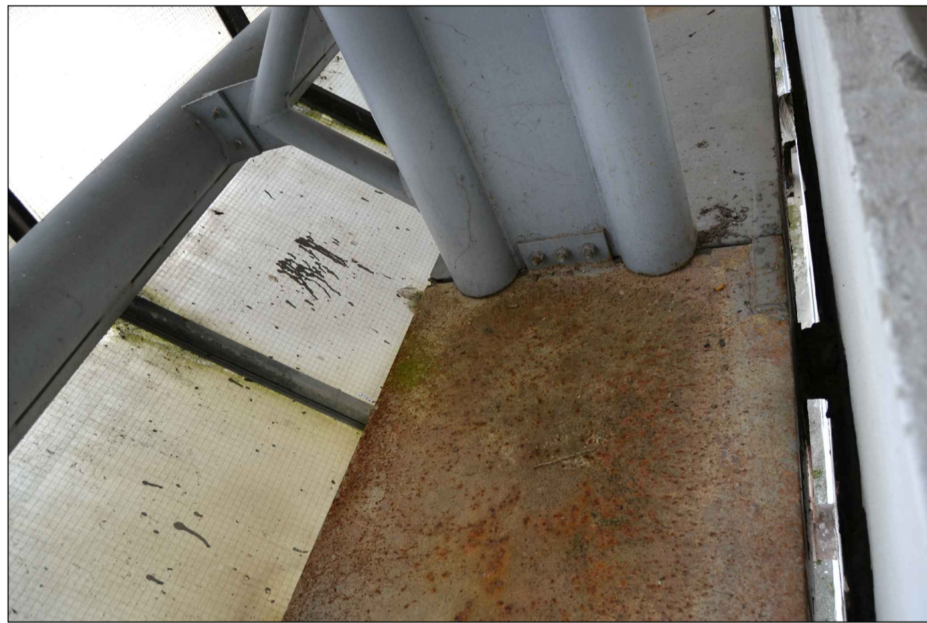
FOTO _ VETRATA NORD DETTAGLIO INTERNO
