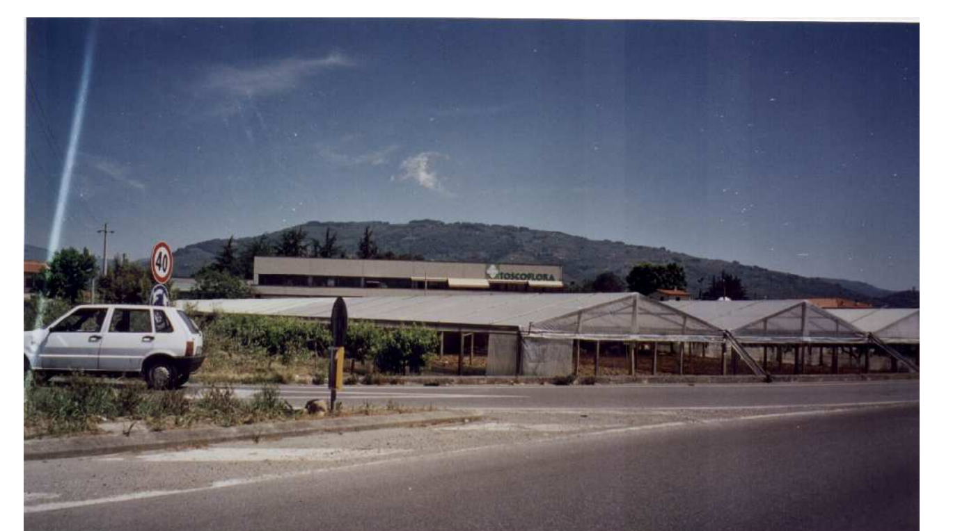
Serre mobili sorrette da una struttura lignea
