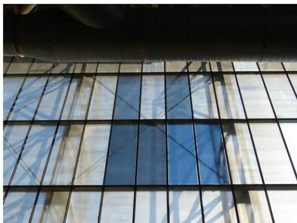
surriscaldamento delle lastre esposte al sole e in ipotesi determinare nel tempo una loro più frequente rottura. Si ritiene che questo aspetto debba essere preso in considerazione.
