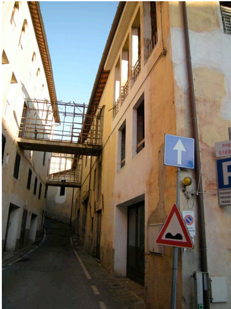
Vista del prospetto di via del Giocatolo – con i corridoi pensili
