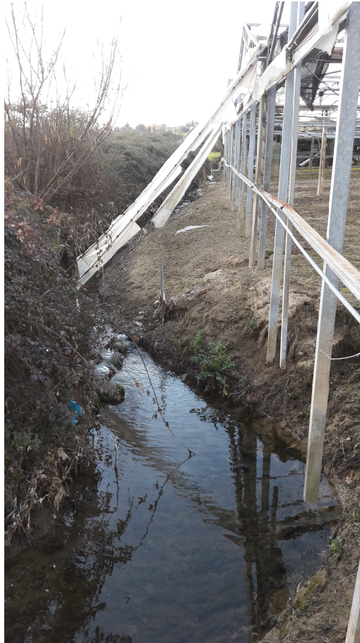
FOTO 8: FOSSO AFFLUENTE DI DESTRA DEL RIO PESCIA MORTA OGGETTO DI INTERVENTO DI PROGETTO DI MASSIMA
