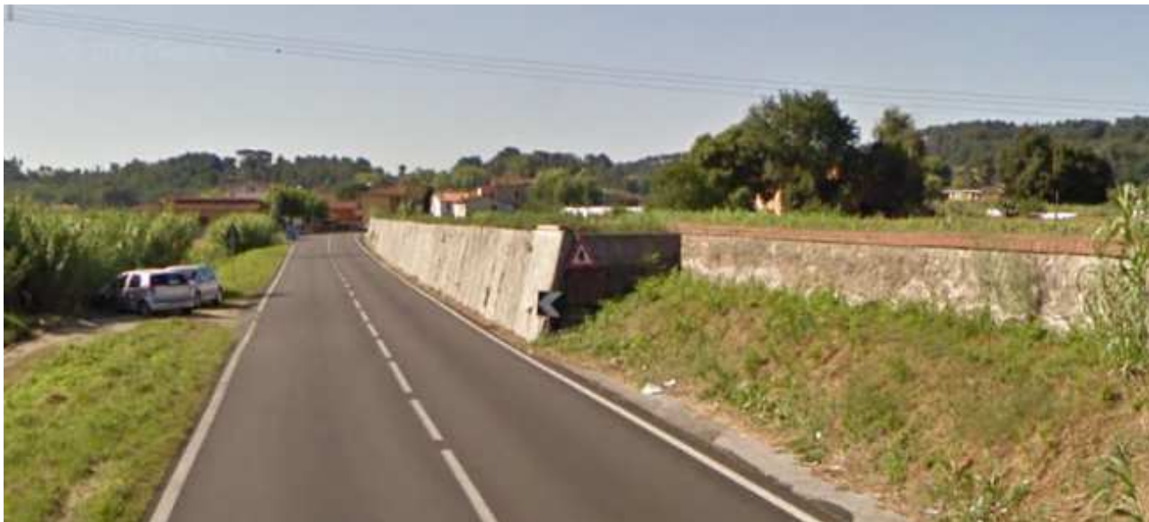
FOTO 3: INIZIO TRATTO DI MURO DI RECENTE REALIZZAZIONE
