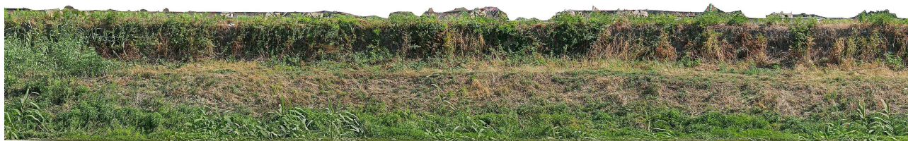
FOTO 1: SPONDA PRESSO SEZIONE N.17 VISTA DALL'INTERNO DEL CORSO D'ACQUA
