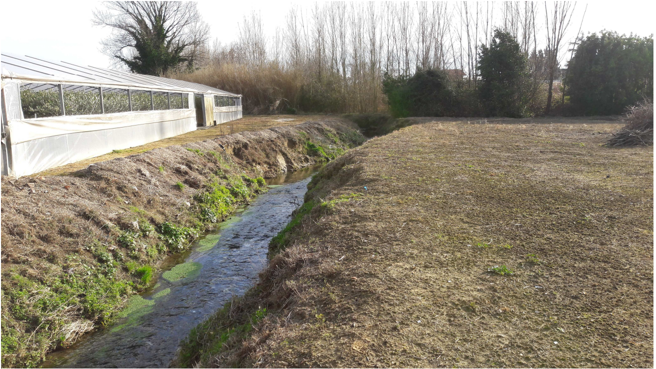
FOTO 10: TRATTO DI RIO PESCIA MORTA A VALLE DI VIA SFERRATO – VISTA DA MONTE
