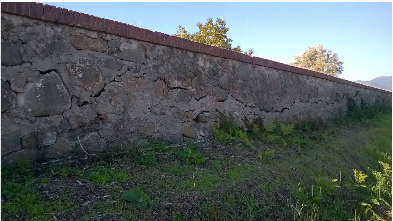
FOTO 2: MURO PRESSO SEZIONE N.9.5 VISTO DA VIA MAMMIANESE
