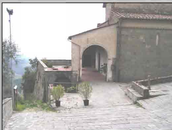
Il portico sopra la cripta e l'attuale ingresso principale
