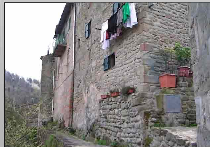
Gli edifici addossati al tracciato delle mura
