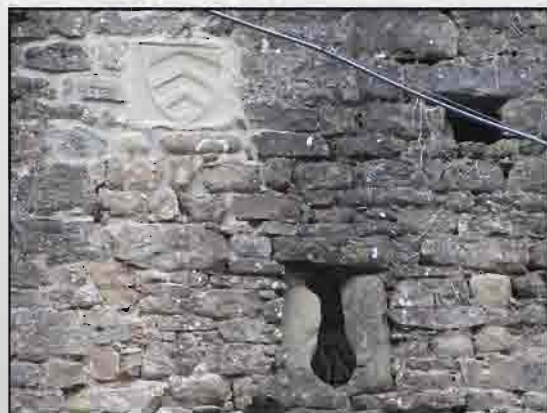
Della Rocca rimangono pochi segni a causa degli eventi bellici e dello stato di abbandono in cui è stata lasciata: essa è quasi completamente distrutta e conserva solamente la solida struttura in pietra serena sagomata disposta a filaretto.
