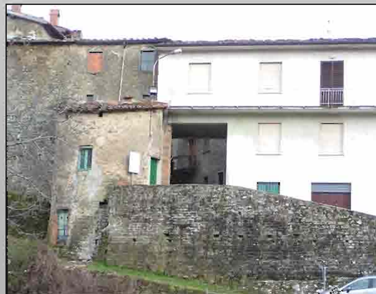
Alcune immagini della porta di accesso completamente modificata
