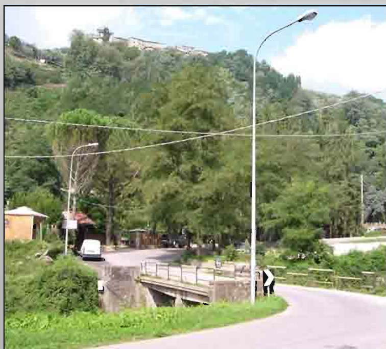
Ponte di Castelvecchio
