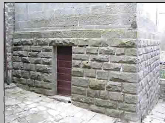
Il campanile: veduta generale e particolare del basamento
