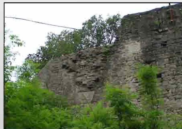
Della Rocca rimangono pochi segni a causa degli eventi bellici e dello stato di abbandono in cui è stata lasciata: essa è quasi completamente distrutta e conserva solamente la solida struttura in pietra serena sagomata disposta a filaretto.
