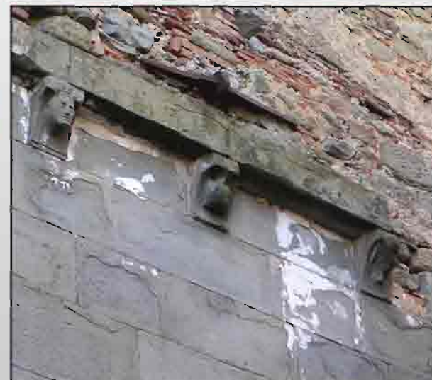
Il fianco settentrionale - particolare della mensola
