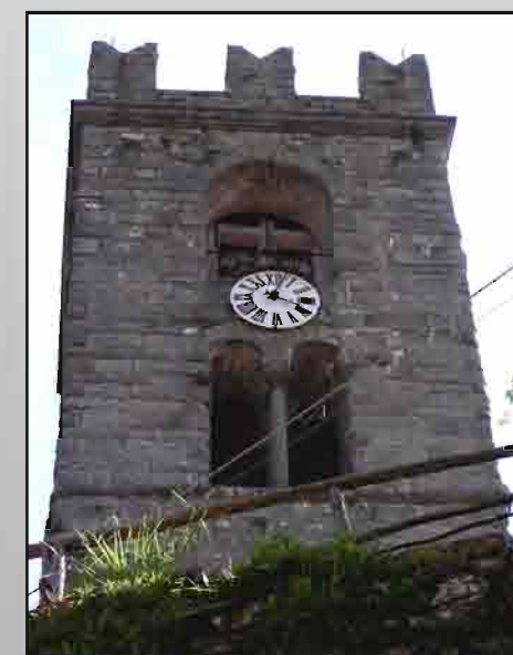
Il campanile prima e dopo i restauri
