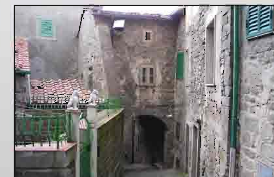
Gli edifici che si ampliano al di sopra delle strade
