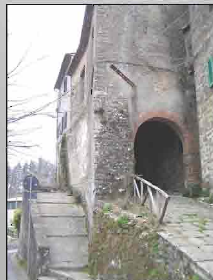
Della Rocca rimangono pochi segni a causa degli eventi bellici e dello stato di abbandono in cui è stata lasciata: essa è quasi completamente distrutta e conserva solamente la solida struttura in pietra serena sagomata disposta a filaretto.
