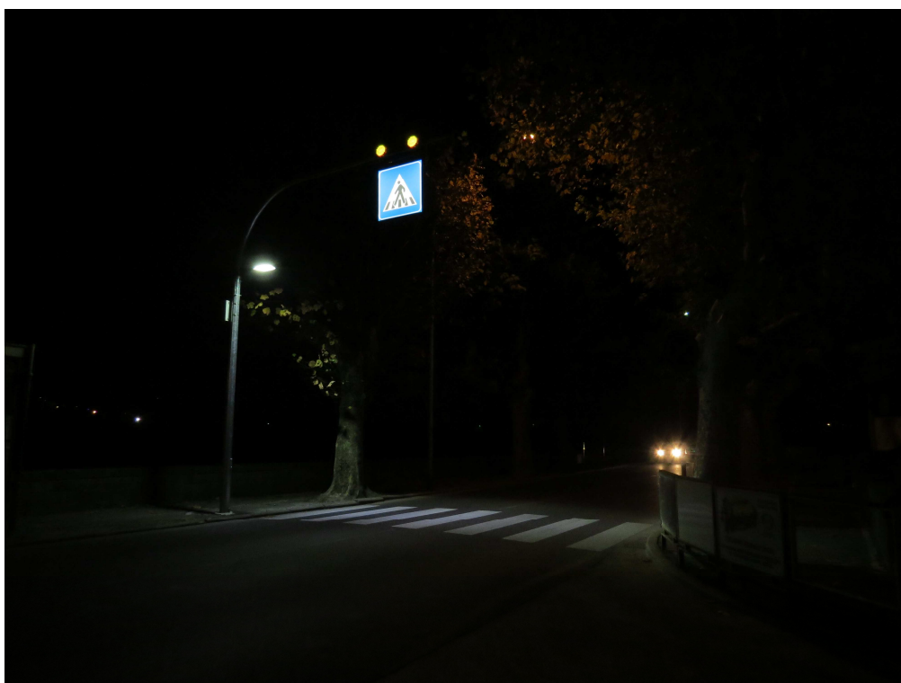
Figura 4: Esempio di attraversamento pedonale protetto – Viale Garibaldi
