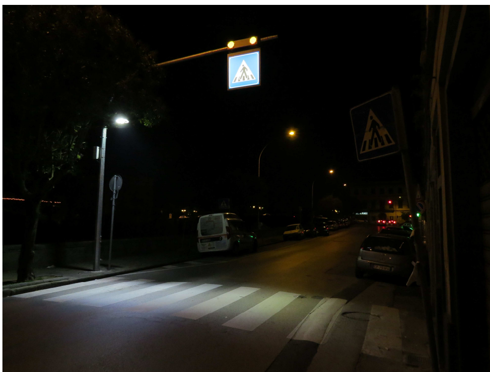
Figura 3: Esempio di attraversamento pedonale protetto – Viale Forti
