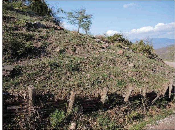
Foto 10 – La viabilità che sale verso le Pracchie, scarpate sopra strada con affioramenti ad elevata frammentazione della Scaglia Toscana e segni contenimento
