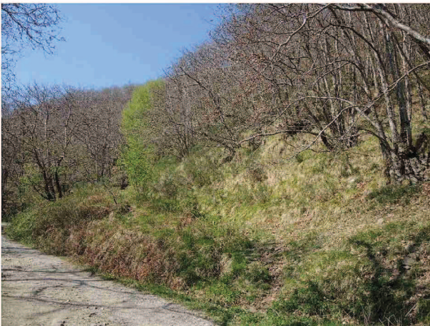
Foto 1 – Scarpata soprastrada ambiente forestale.
