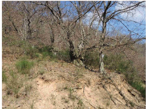
Foto 4 – Scarpata soprastrada ambiente forestale (castagneto) con evidenti segni di erosione.
