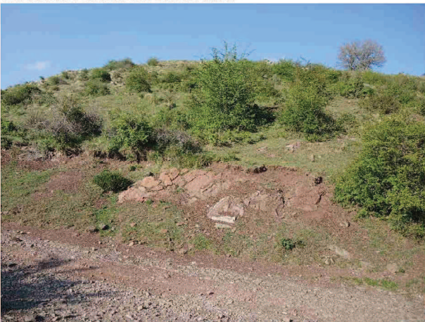
Foto 11 – La viabilità che sale verso le Pracchie, scarpate sopra con affioramenti ad elevata frammentazione della Scaglia Toscana e segni di erosione. Presenza dell'habitat 5130 e dell'habitat 6210.
