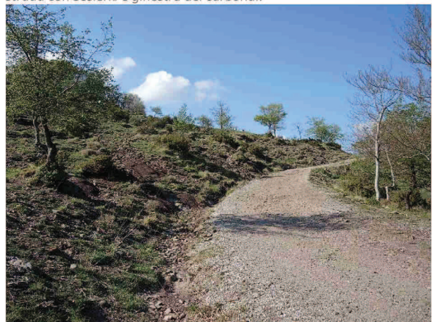
Foto 8 – La viabilità che sale verso le Pracchie, scarpate sopra e sotto strada con affioramenti ad elevata frammentazione della Scaglia Toscana.
