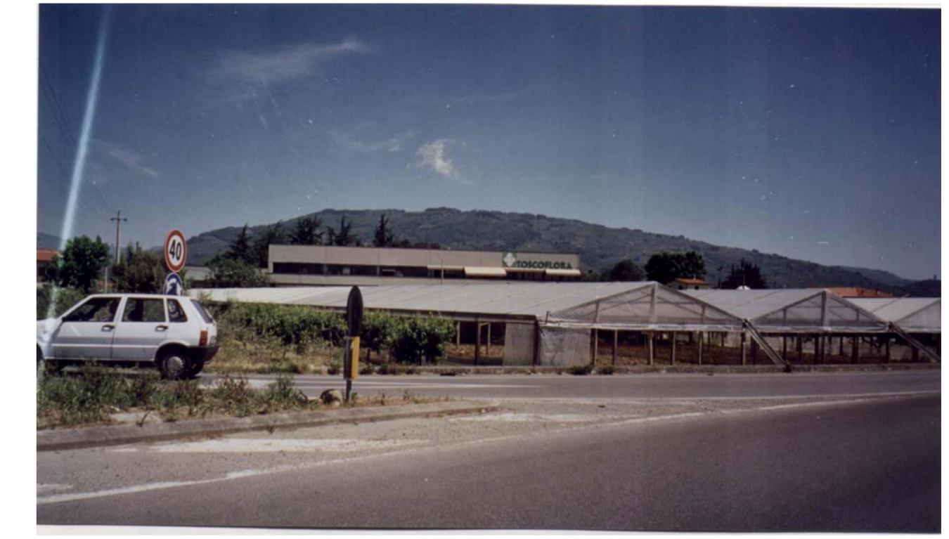
Serre mobili sorrette da una struttura lignea
