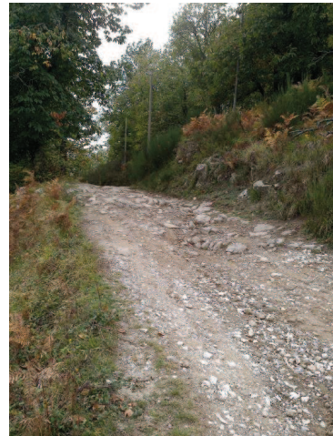
Foto 23: demolizione trovanti rocciosi
