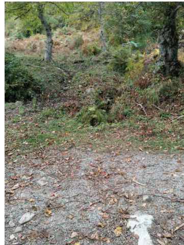
Foto 31 attraversamento da rifare previa demolizione vecchia opera
