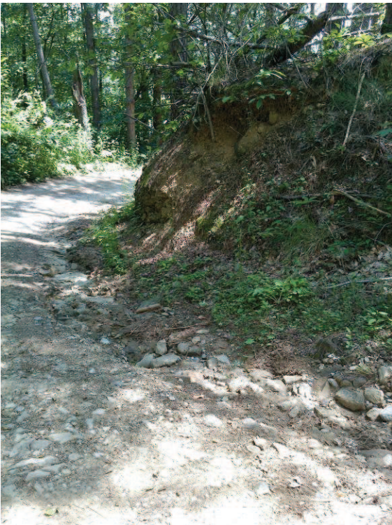
Foto 58 solchi di erosione per cattiva regimazione
