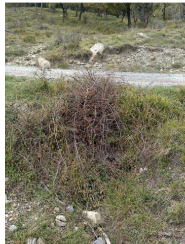
Foto 20: attraversamento da ripristinare
