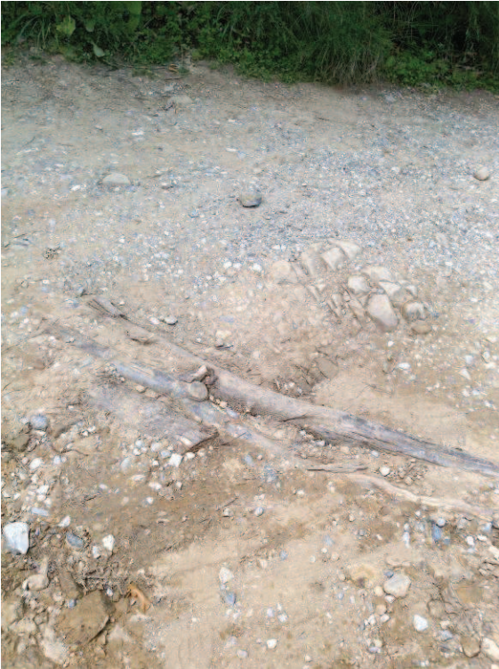
Foto 53 vecchio sciacquo da demolire e sostituire con basto rovescio
