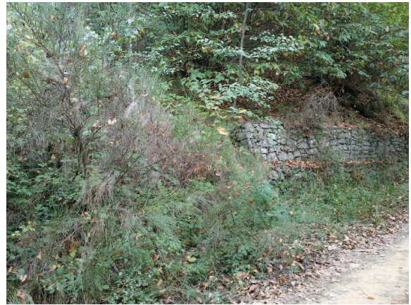
Foto 43 scarpata di monte da risagomare con palificata
