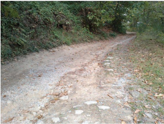
Foto 38 solchi di erosione per mancata regimazione
