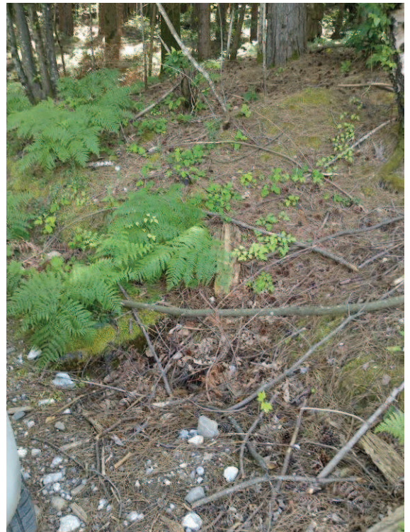
Foto 60 necessità di apertura fossetto e rifacimento attraversamento
