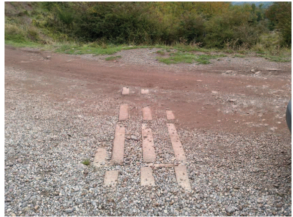
Foto 15: attraversamento da riaprire o demolire
