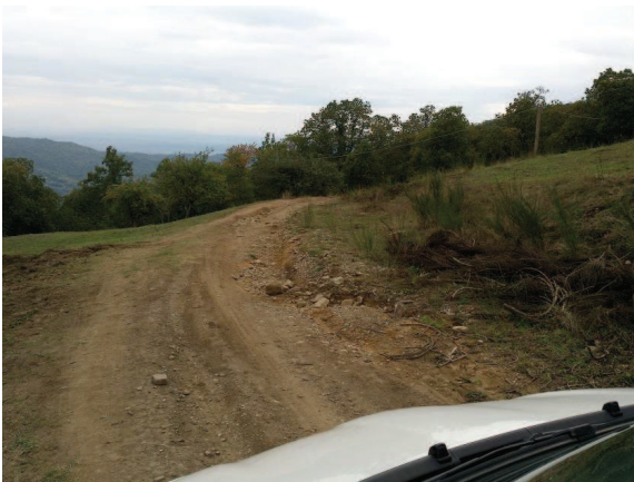
Foto 34 scarpata di monte da riprofilare
