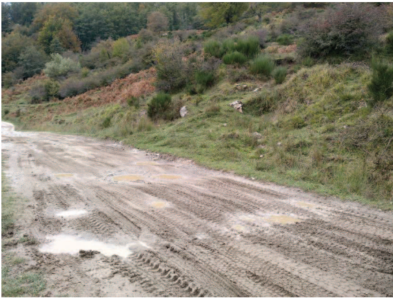
Foto 21: livellamento e realizzazione attraversamento
