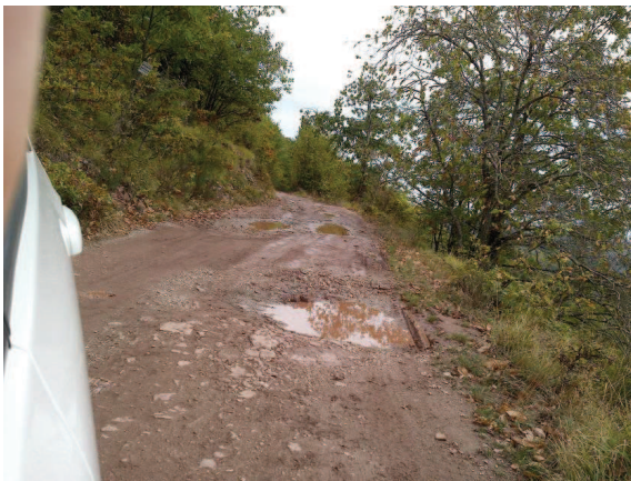
Foto 10 : necessità di livellamento
