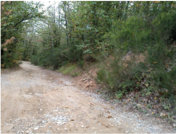
Foto 45 modesti crolli sulla strada. Rifacimento canaletta e relizzazione palizzate
