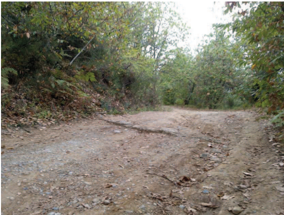
Foto 46 livellamento e realizzazione attraversamento
