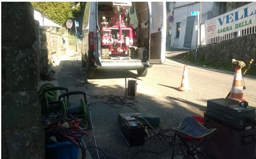
Profilo ST1 – Stralcio dello stendimento geofonico con geofoni da 14 Hz a spaziatura 2m.
