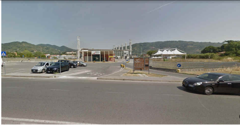
Accesso al fabbricato ed all'area di lavoro
