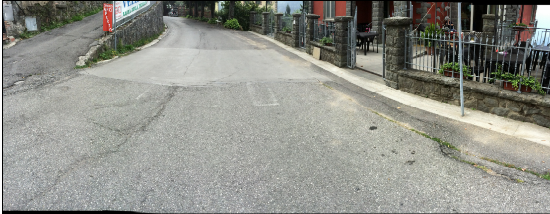
(Foto n. 9) Avvallamenti e lesioni su Via PROVINCIALE in loc. Borgo G. Matteotti
