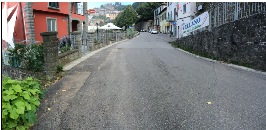
(Foto n. 11) Avvallamenti e lesioni su Via PROVINCIALE in loc. Borgo G. Matteotti
